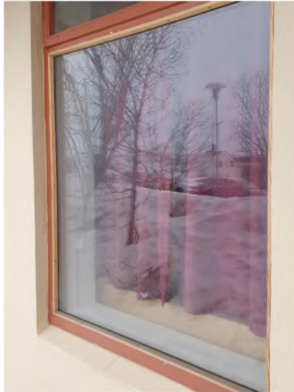
Mynd 18. Gluggi á kjallara Suðurhliðar
