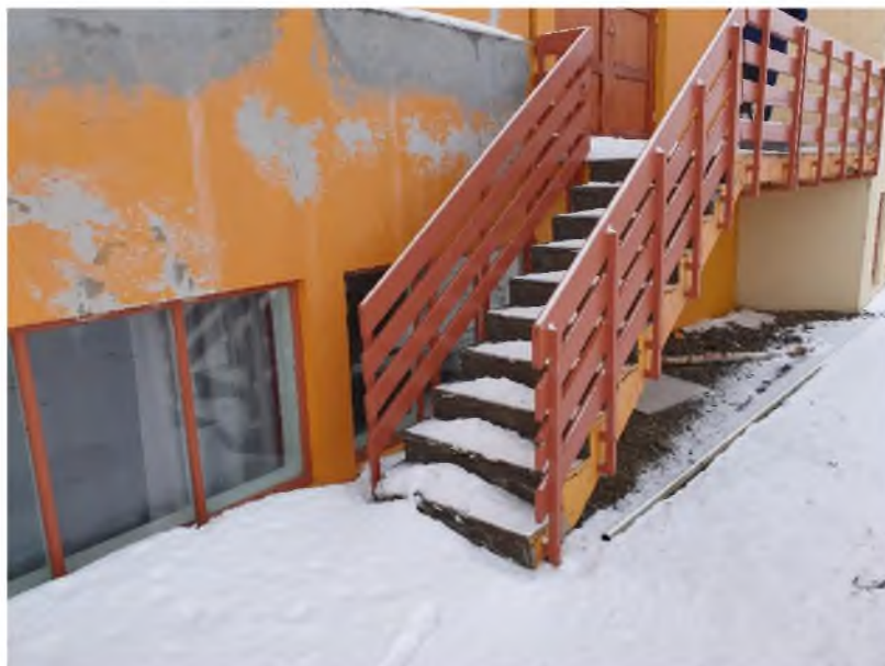
Mynd 21. Steyptar svalir og útitröppur á Norðurhlið
