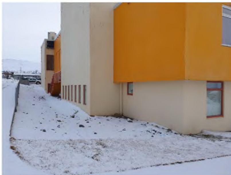
Mynd 10. Útveggur NV-horn
